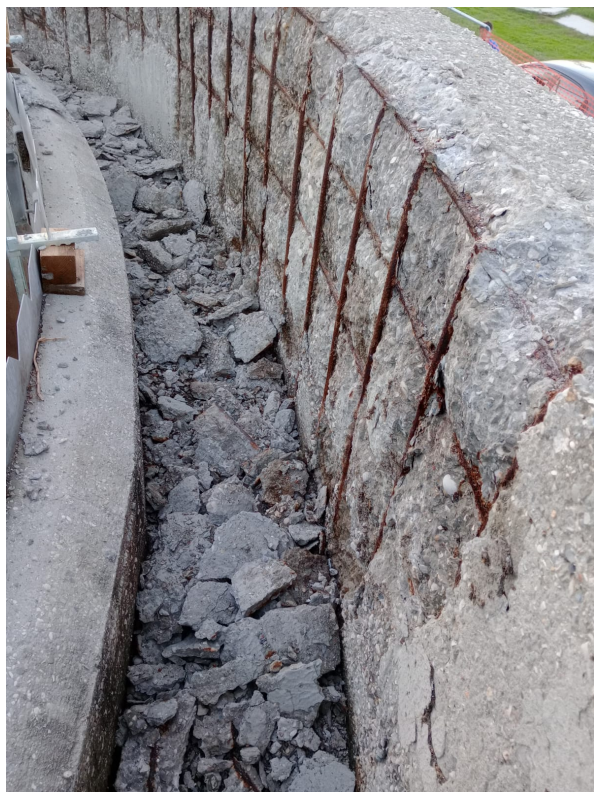
Esempi di corrosione del ferro e disgregazione del calcestruzzo in due vasche di raccolta acqua potabile - DRACO Italiana SpA©
