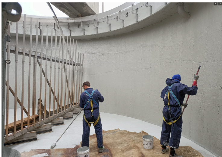
Applicazione a rullo di EPOWALL ALM in una vasca di ispessitore di fanghi - DRACO Italiana SpA©
