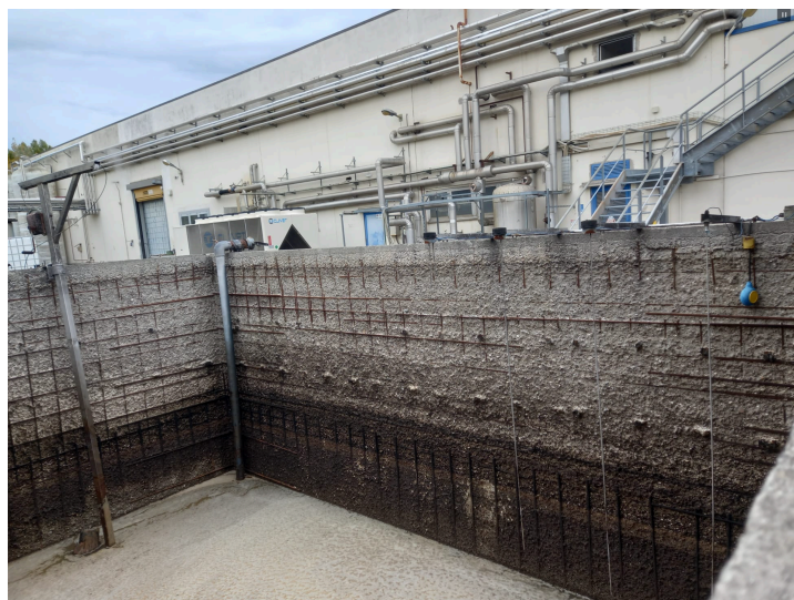
Esempi di corrosione del ferro e disgregazione del calcestruzzo in due vasche di raccolta acqua potabile - DRACO Italiana SpA©
