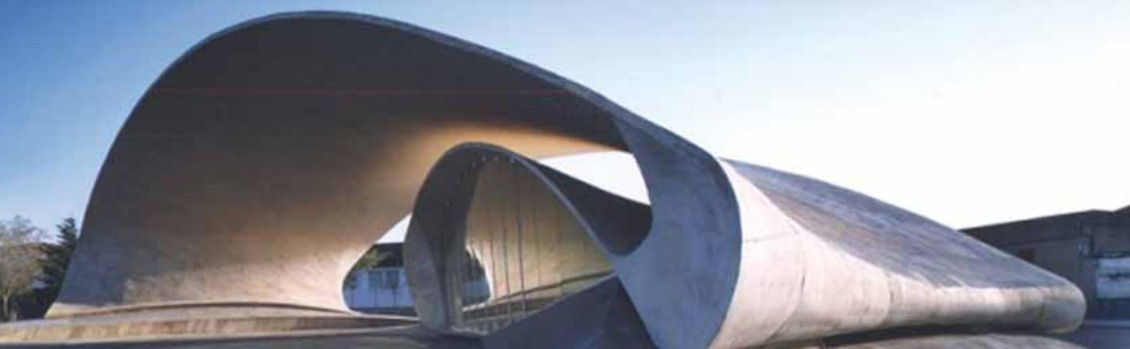
La stazione degli autobus realizzata dall'architetto Justo Garcia Rubio sorge in un piccolo paesino ad ovest di Madrid. Si tratta di un'architettura "total-design" realizzata in un unico materiale: il calcestruzzo, che si arrotola e si piega come un foglio per coprire l'area esterna di sosta degli autobus ed uno spazio interno attrezzato per uffici, caffetteria e servizi igienici.
