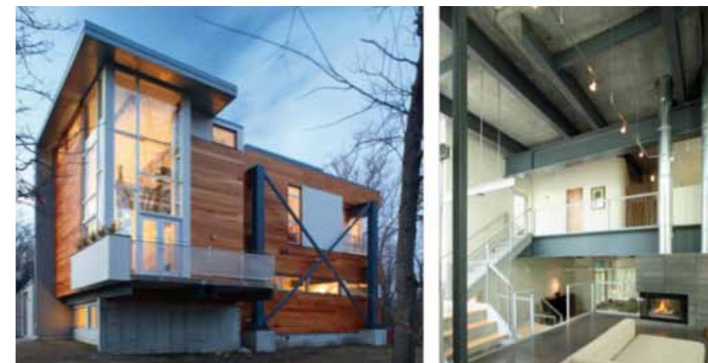
Big Dig House Speed Single Design: esempio di riuso della carpenteria metallica di un viadotto
