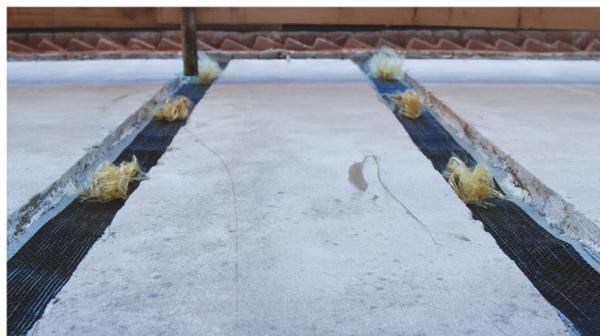
Posa dei tessuti in fibra di carbonio ARMOSHIELD C sulle corsie di malta e inserimento dei connettori ARMOGRIP
