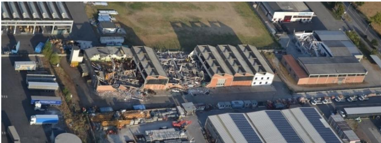
Crolli di edifici industriali prefabbricati @Sismocell
