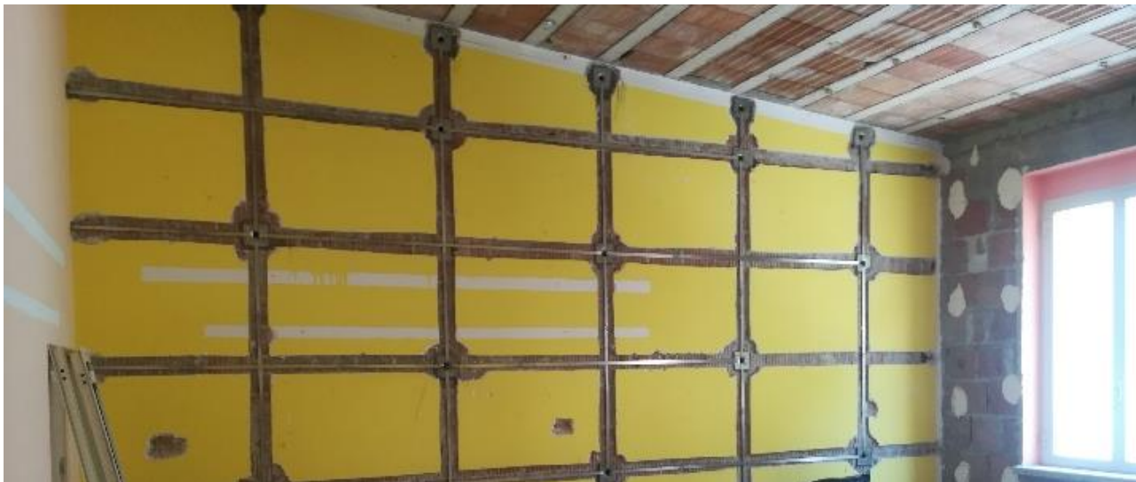
CANTIERE EDIL CAM SISTEMI ® IN VIA GIOVANNI XXIII (PESCHE – IS)
