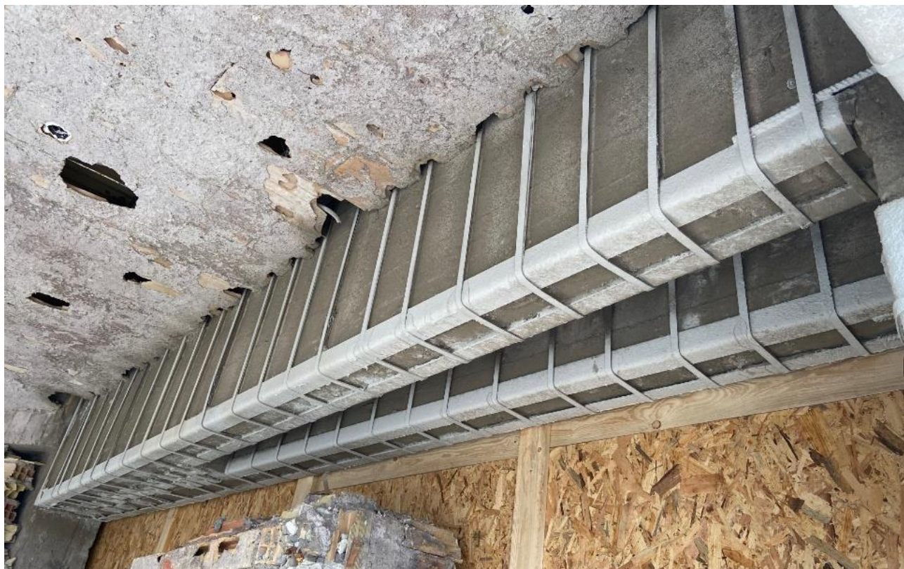
CANTIERE EDIL CAM SISTEMI ® IN VIA VENETO (ROMA - RM)
