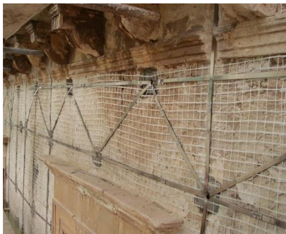
CANTIERE EDIL CAM SISTEMI® IN VIA XX SETTEMBRE (L'AQUILA - AQ) - CORDOLO CAM®
