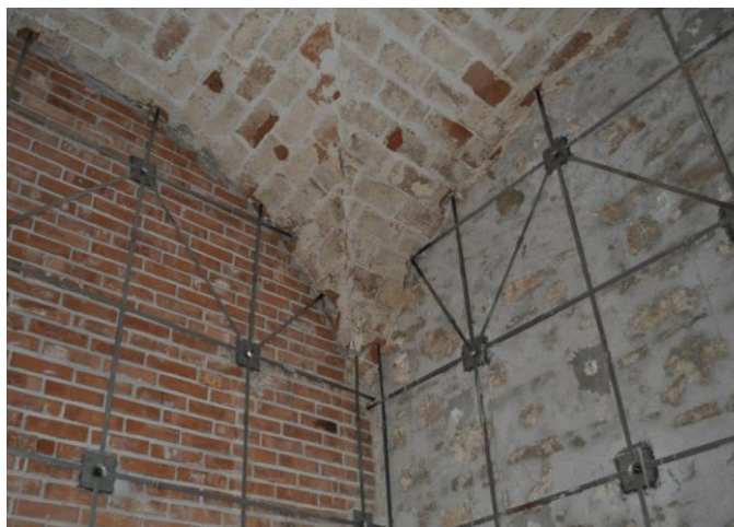
CANTIERE EDIL CAM SISTEMI® IN VIA XX SETTEMBRE (L'AQUILA - AQ) - CORDOLO CAM®
