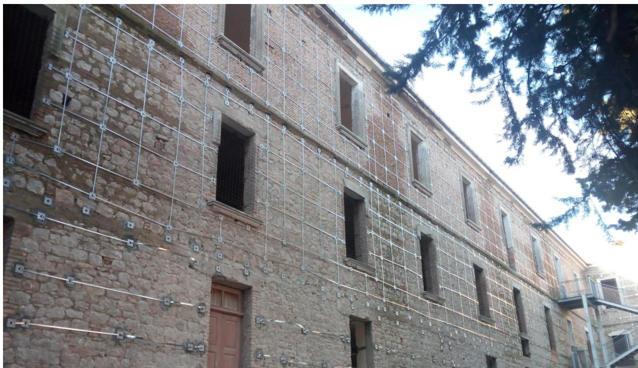
CANTIERE EDIL CAM SISTEMI ® IN VIA S. DEMETRIO (PIETRAGALLA - PZ)
