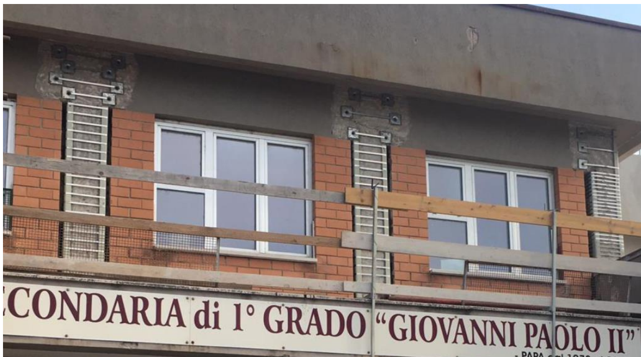
CANTIERE EDIL CAM SISTEMI ® IN VIA OMERIO (LESINA - FG)
