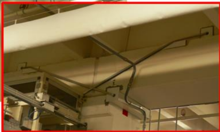
CANTIERE EDIL CAM SISTEMI ® – STABILIMENTO INDUSTRIALE A DESENZANO SUL GARDA (BS)
