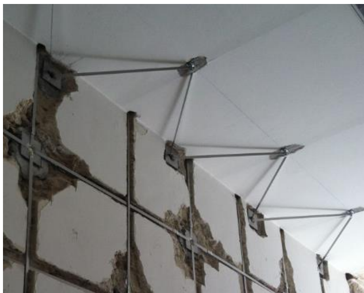
ARPIONATURA DEL SOLAIO CON NASTRI CAM®
