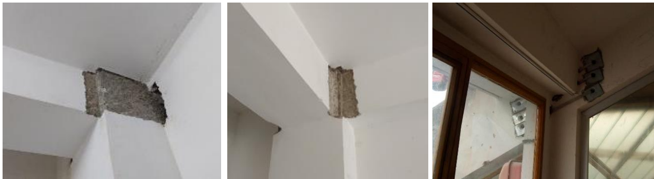
MINIMA PREPARAZIONE DELLE SUPERFICI E GESTIONE DELLE INTERFERENZE PER LA POSA EDIL CAM ® SISTEMI
