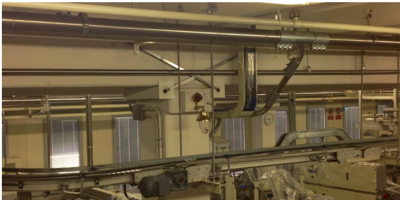
CANTIERE EDIL CAM SISTEMI ® – STABILIMENTO INDUSTRIALE A DESENZANO SUL GARDA (BS)
