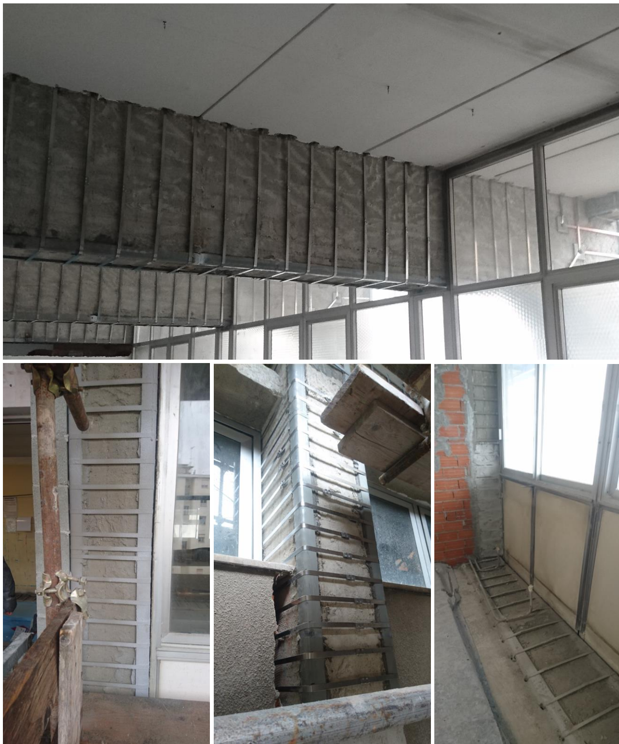
CANTIERE EDIL CAM SISTEMI ® IN VIA MADAMA CRISTINA (TORINO - TO)
