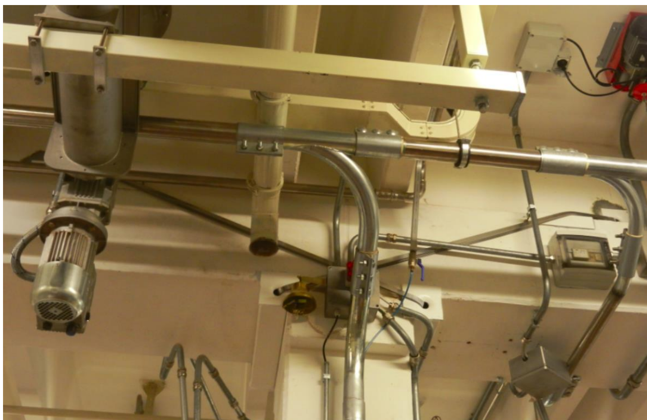
CANTIERE EDIL CAM SISTEMI ® – STABILIMENTO INDUSTRIALE A DESENZANO SUL GARDA (BS)
