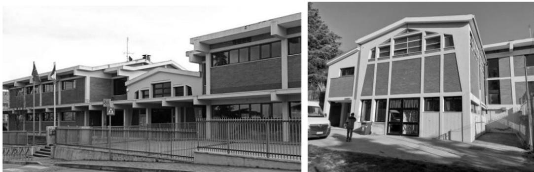
Tuttavia, nonostante la buona qualità costruttiva, i risultati dei numerosi carotaggi su travi e pilastri (ne sono stati fatti ben 28) hanno evidenziato una bassa resistenza del calcestruzzo in diverse parti della struttura, con valori di resistenza ben al di sotto non solo degli standard attuali, ma anche della resistenza prevista nel progetto originario, con un valore medio di **8,42 Mpa**.
