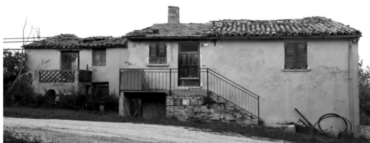
Costruzioni miste in muratura e conglomerato cementizio armato, anni '70-'80, fotografie SismaCoat
