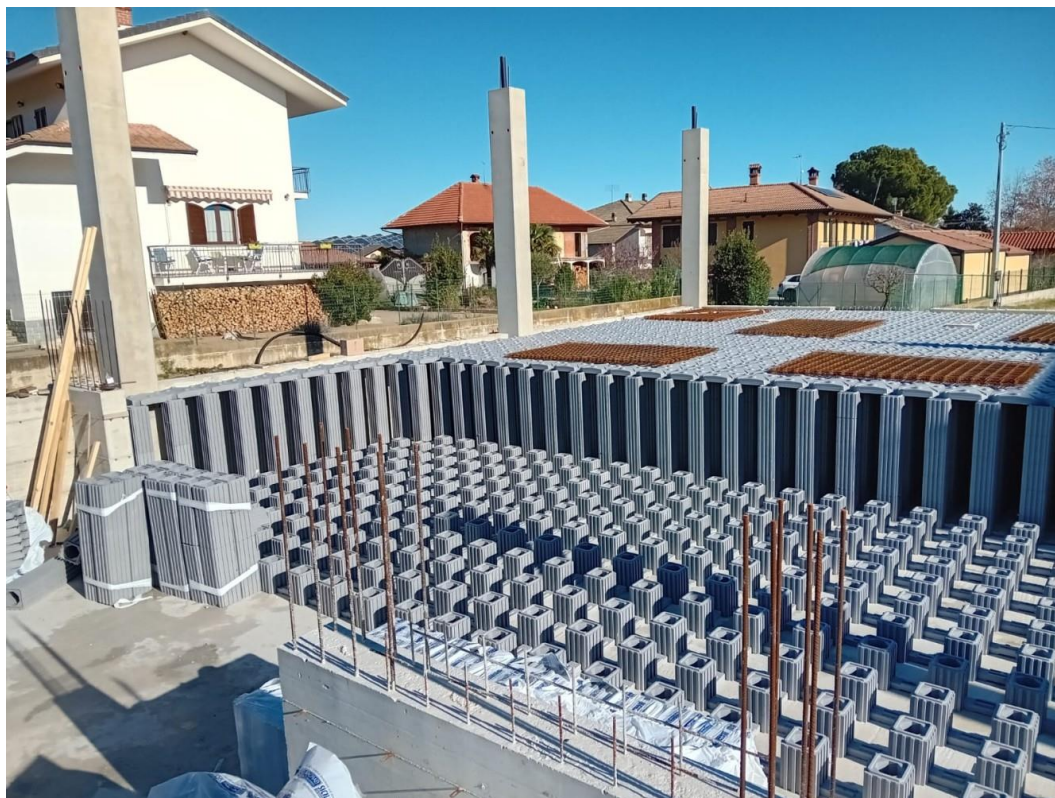
Foto 2: Posa in opera Vespaio Aircrab® di altezza 160 cm - C. re Cavour (To).
