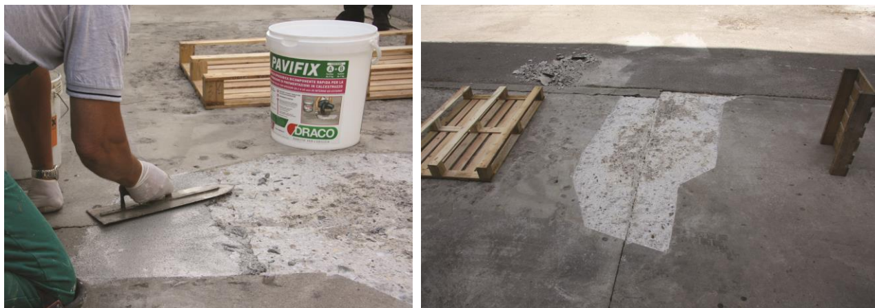
Figura 2 – Applicazione di PAVIFIX.
