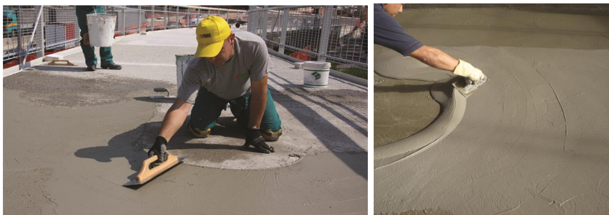
Figura 1 – Applicazione di EPOMALT FAST 100.
