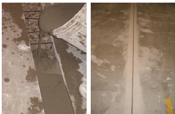
Figura 3 – Esempio di realizzazione del giunto a travetto.
