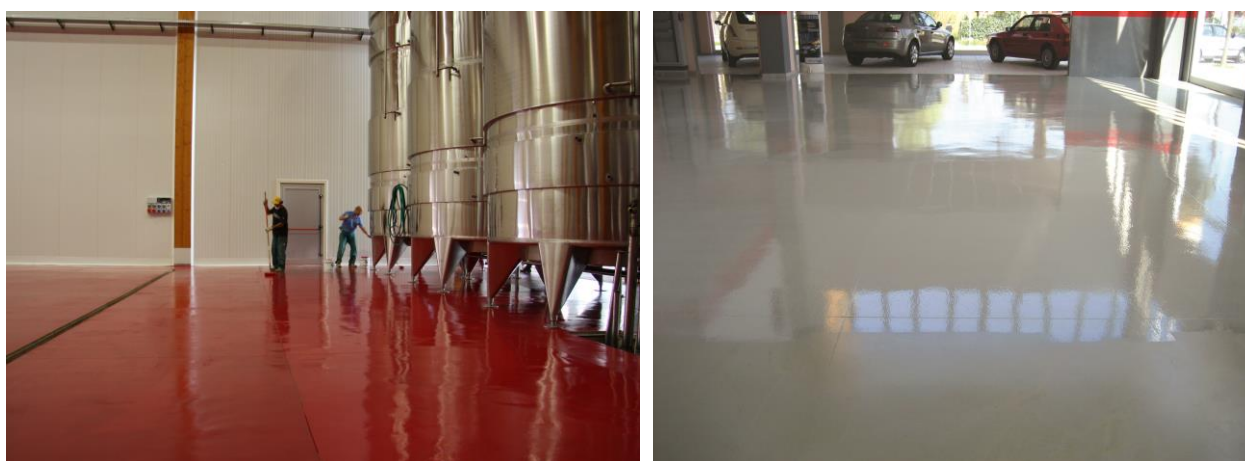
Figura 5 – Due esempi di rivestimento realizzato con WEPOX COLOR.
