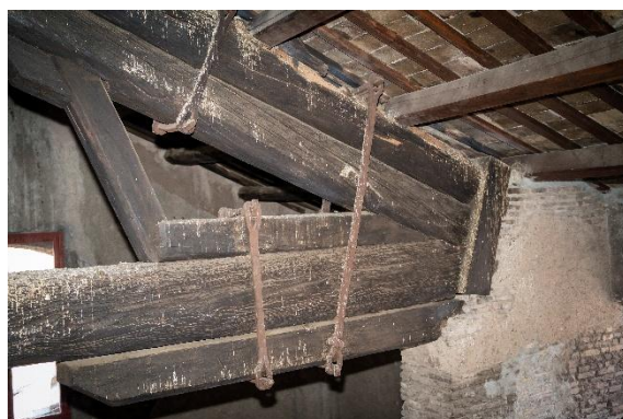
Innesto di una capriata in legno con la muratura portante
