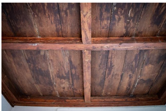
Solaio in legno a doppia orditura
