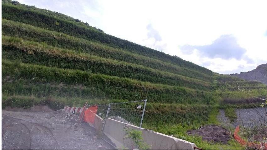
*Figura 4. Vista laterale del rilevato in terra rinforzata con paramento verde a 70° e geogriglie di rinforzo, in corrispondenza della sezione massima (circa 25 metri).*
