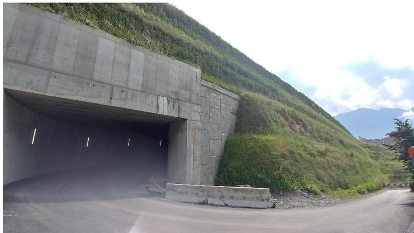
*Figura 5. Vista del rilevato in terra rinforzata con paramento verde a 70° e geogriglie di rinforzo, in corrispondenza dell'intersezione con lo scatolare.*
