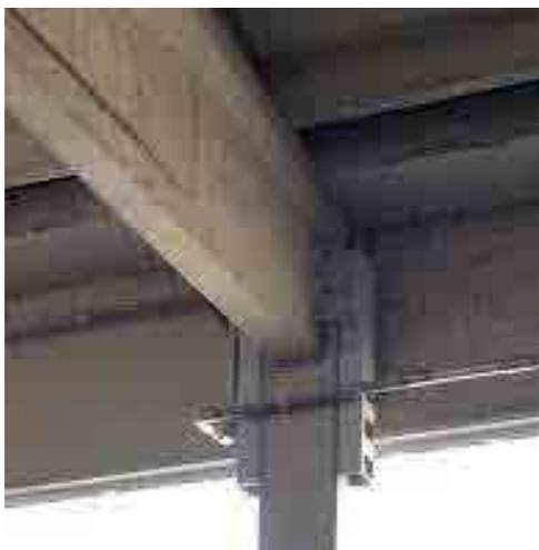
Connessione di tipo rigido, sovrar resistente
