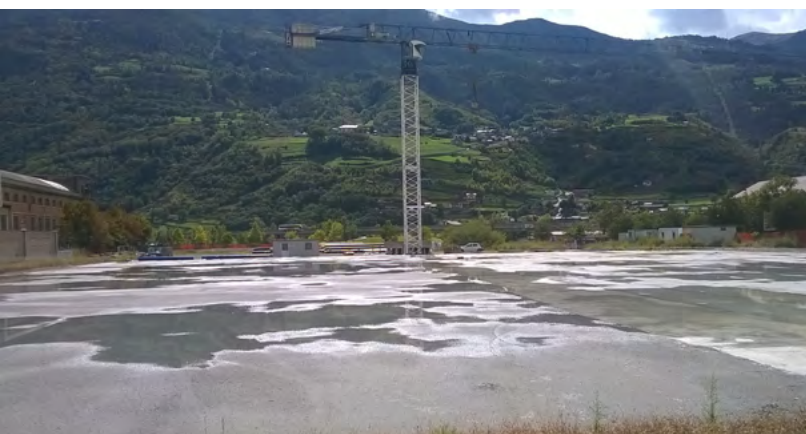
L'area prima dell'inizio dei lavori.
