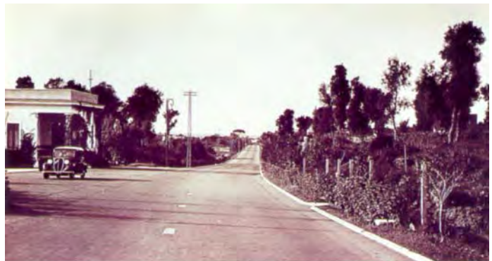
Fig. 8 L'autostrada dei Laghi a carreggiata unica con due corsie
