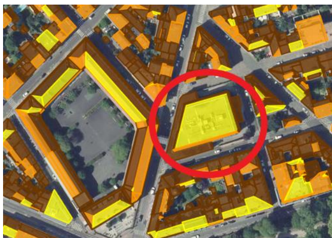
Fig. 11 – partendo da un'immagine aerea, archelios MAP fornisce informazioni sull'irraggiamento incidente sulle coperture
