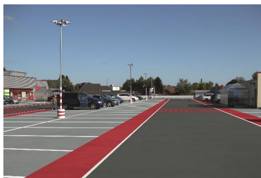
Parcheeggio a raso impermeabilizzato e rivestito con le soluzioni Triflex - ©Triflex
