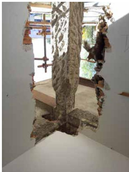
Foto 2. Pilastro scalpellato oltre la posizione delle armature e reso scabro per l'aderenza del nuovo getto
