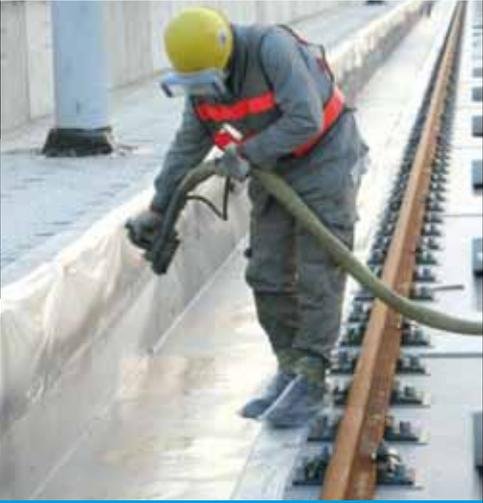
MEMBRANA LIQUIDA, BICOMPONENTE, ELASTICA, IN POLIUREA PURA VAPORIZZATA A CALDO
