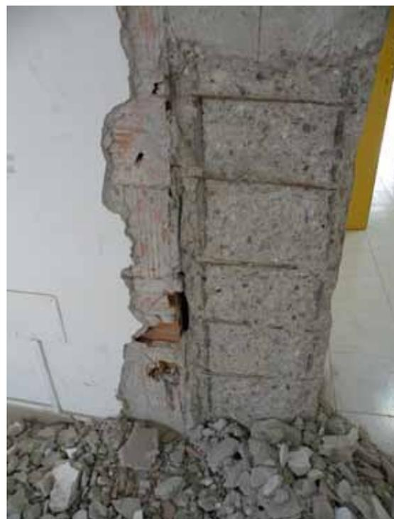
Foto 1. Pilastro in fase di isolamento
