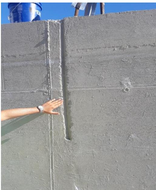
Trattamento superficiale pareti e giunti di fessurazione WS BREAK JOINT con ciclo Penetron® Standard
