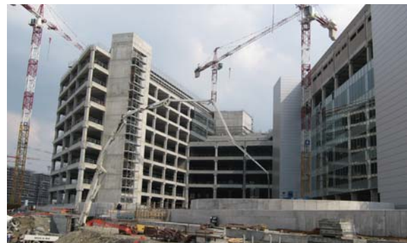
Figura 14 - Strutture prefabbricate ed. n.1 e n.2
