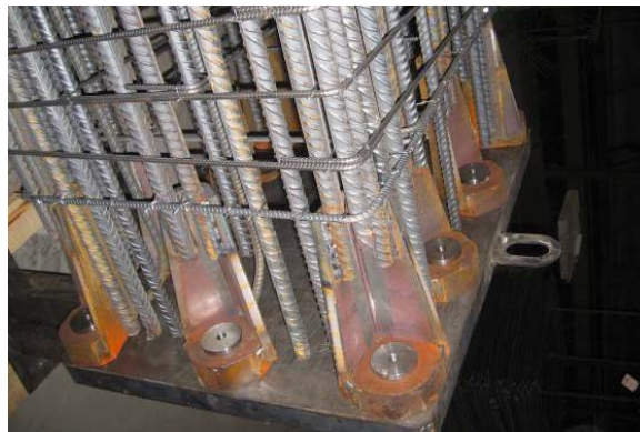
Figura 17 - Inserti speciali alla base dei pilastri
