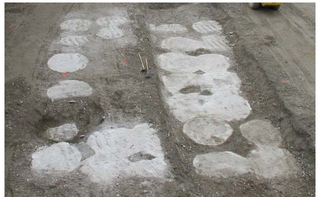
Figura 4 - Estradosso Colonne vano scala
