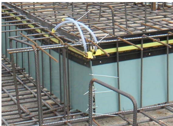
Figura 7 - Elemento di prefessurazione
