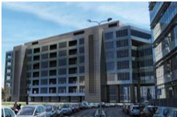
Figura 23 - Nuova sede SKY Italia edificio 3
