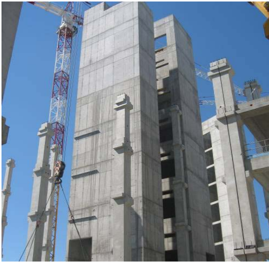
Figura 18 - Vista pilastri e muri vani scala
