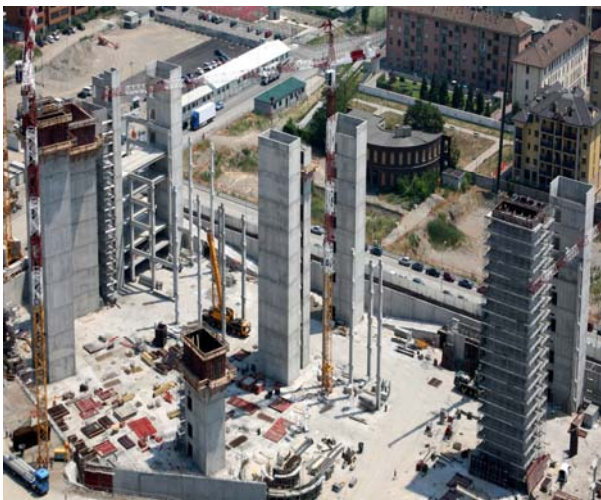
Figura 19 - Esecuzione strutture verticali in opera
