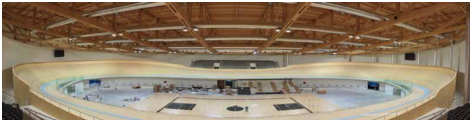
Copertura di un velodromo coperto in Portogallo, luce libera di 80 m (foto Rubner Holzbau S.p.A. di Bressanone)
