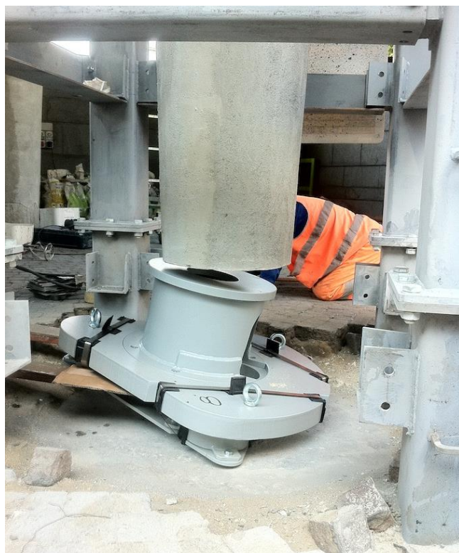
Figura 9. Inserimento dei "tripodi" sotto i pilastri, preventivamente tagliati alla base.
