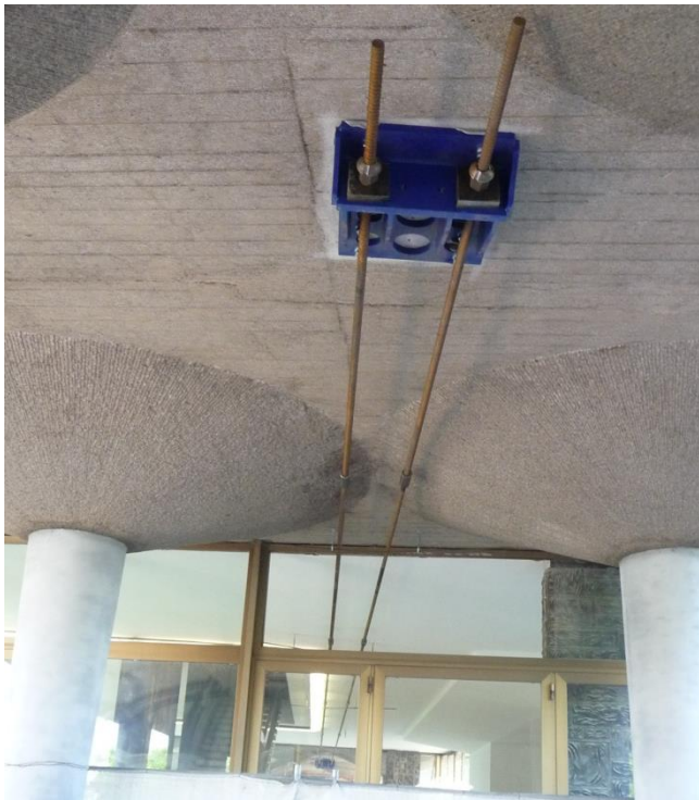
Figura 11. Sistema di tiranti per il rilascio dei fabbricati ancorati alle estremità a carpenterie metalliche di contrasto inghisate all'intradosso del primo solaio.
