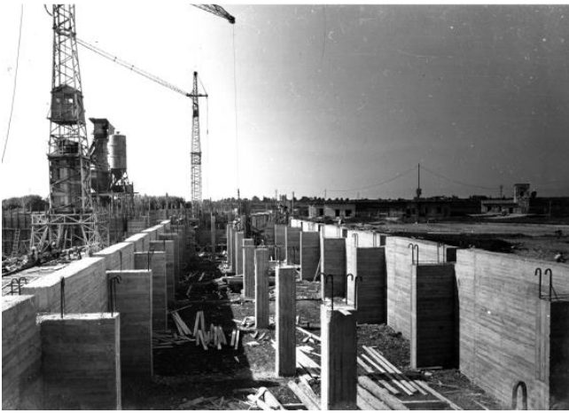
Figura 5. Foto d'epoca che mostra la geometria della struttura interrata.
