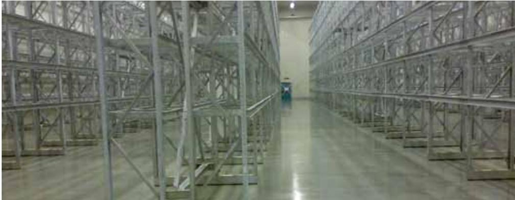
**L**e scaffalature industriali sono strutture metalliche particolari, sia dal punto di vista costruttivo che dei carichi, e solo in parte riconducibili a edifici realizzati con sistemi costruttivi tradizionali.
