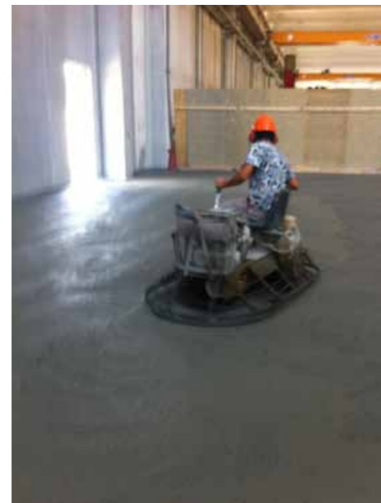
Operazioni di finitura superficiale
